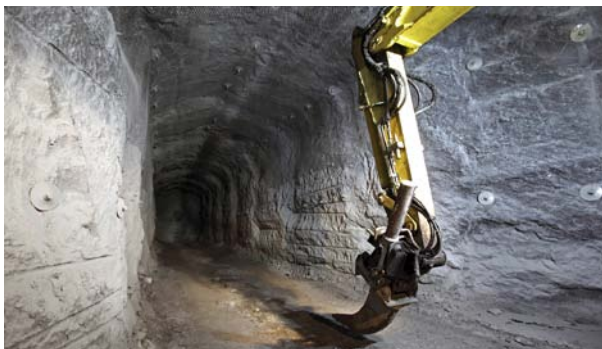
Posiva aloitti ONKALOn rakentamisen vuonna 2004.
